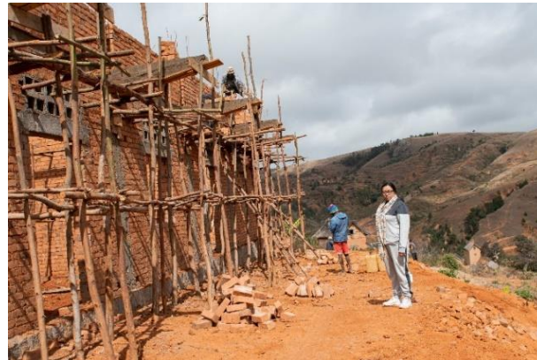
Die Projektleiterin Frau Taratra Rakotomamonjy vor dem fast fertigen Rohbau. Hier wird bald die Vorschule starten können.
