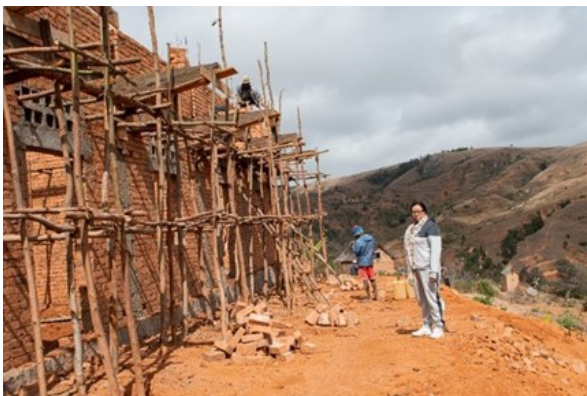
Frau Taratra bei der Besichtigung und Kontrolle der Baustelle.
