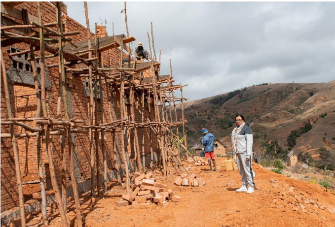
Unsere Projektleiterin Frau Taratra, bei der Besichtigung der Baustelle
